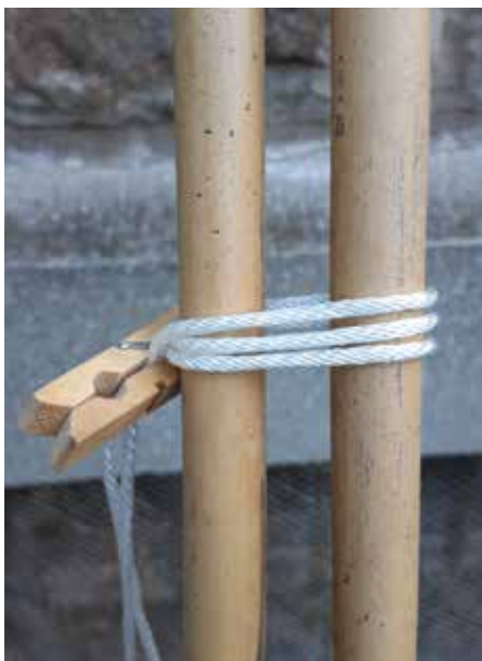
Beweglicher Knoten für die schrägen Stangen
