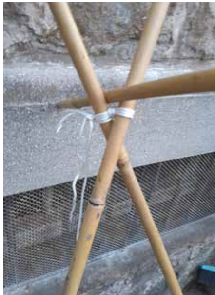
Auflegen und Verknoten der oberen Querstange
