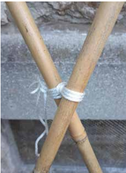
Auflegen und Verknoten der oberen Querstange
